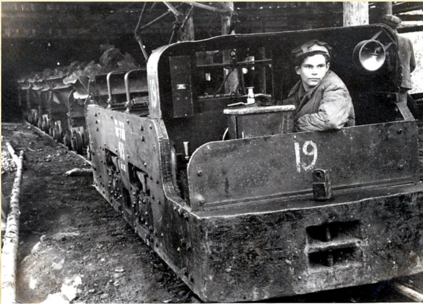
ФОТОГРАФИЯ. ТАШТАГОЛЬСКИЙ ЖЕЛЕЗНЫЙ РУДНИК В ГОРНОЙ ШОРИИ – СЫРЬЕВАЯ БАЗА КУЗНЕЦКОГО МЕТАЛЛУРГИЧЕСКОГО КОМБИНАТА. ОТСЮДА РУДА ИДЕТ В ДОМЕННЫЙ ЦЕХ КОМБИНАТА. НА РУДНИКЕ ПОЧТИ ВСЕ РАБОТЫ МЕХАНИЗИРОВАНЫ. ЭЛЕКТРОВОЗ С РУДОЙ ВЫХОДИТ ИЗ ШТОЛЬНИ. ФОТОХРОНИКА ТАСС. 1949Г. ФОТОФОНД. ОП.8 ДОП, Д.269.
