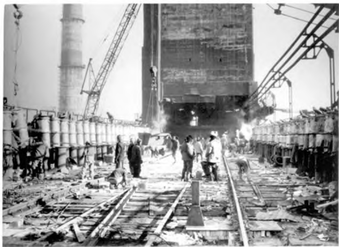
Ремонт кладки коксовой батареи №4 Кемеровского коксохимического завода. 1988 год.
