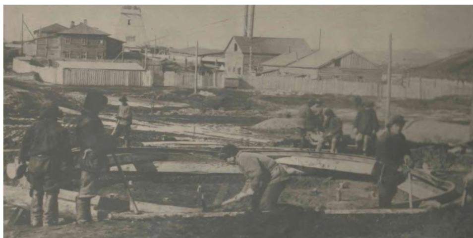
На строительстве шахты «Коксовая-1». 1929 год
