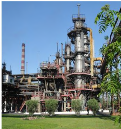
Установка КФС, пущенная в ОАО «Кокс» в 2001 году. 2012 год.
