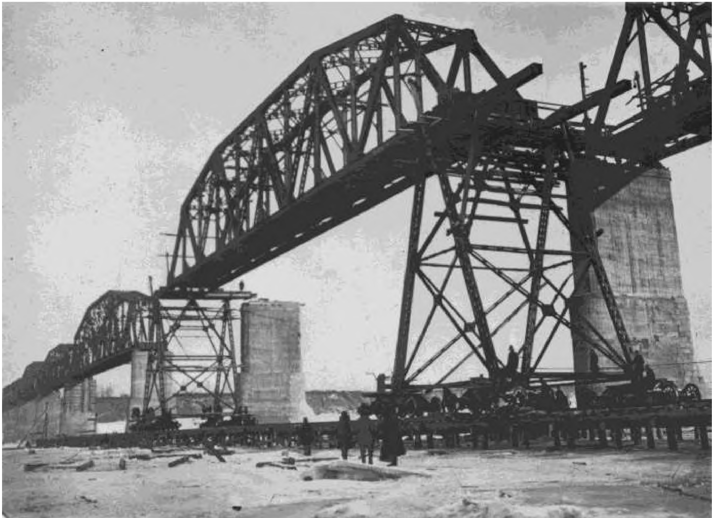
Фотография «Наводка фермы железнодорожного моста через р. Томь. Кемерово». 1933 г.
