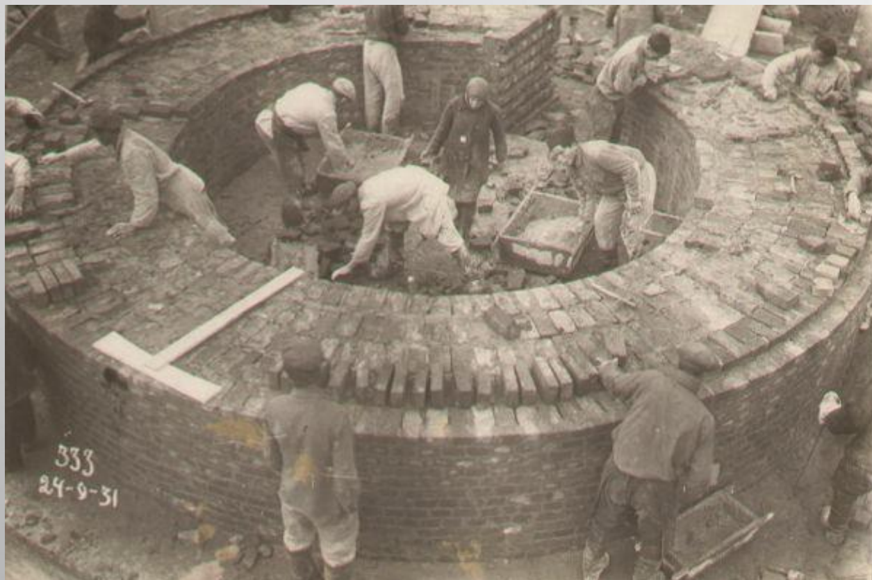
Закладка трубы 4-й коксовой батареи на новом коксохимзаводе. 1931
