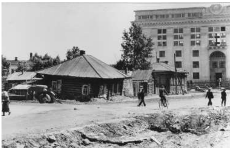
Строительство здания обкома КПСС. Площадь Советов. в г. Кемерово, 1957 г. ГКУ КО «ГАКО». Фотофонд. Оп. Фотоальбомов. Д. 75.
